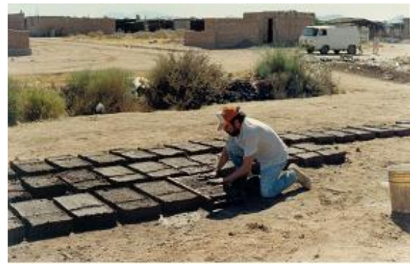
Figura 6. Fabricación de adobes para los muros de la casa.
