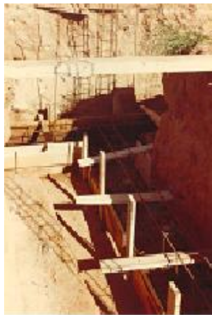
Figura 7. Ejecución de la cimentación a base de zapatas corridas y muros de contención.
